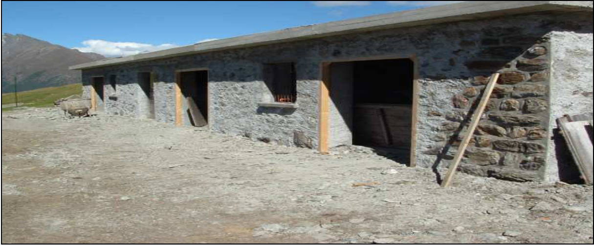
Fabbricati di malga Calvo
