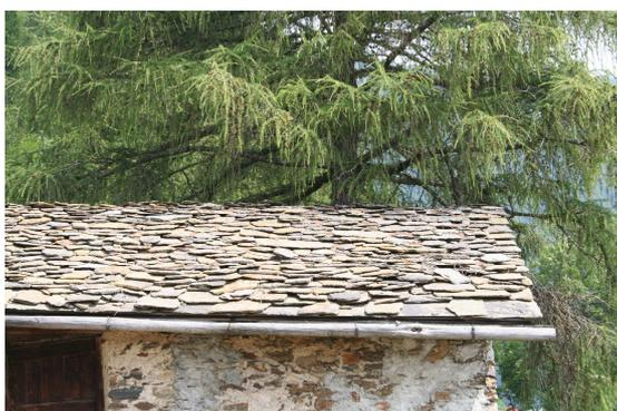
**Fig. 140 : Tetto in lastre di micascisto
