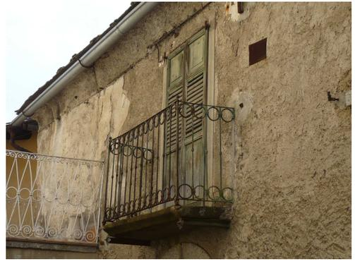
**Fig. 57 : Balcone con struttura in pietra e parapetto in ferro (Vione, edificio 1.71)**
