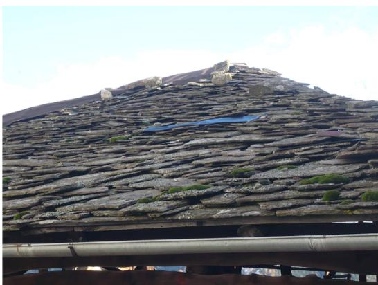
**Fig. 138 : Tetto in lastre di micascisto
