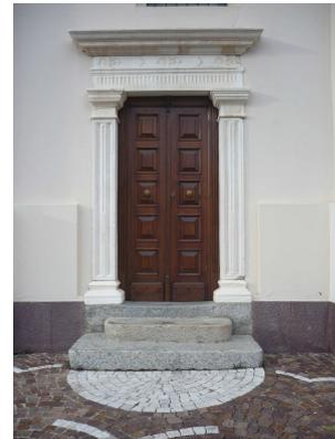
**Fig. 64 : Portale con traverso rettilineo in marmo (Vione, edificio 1.1)**
