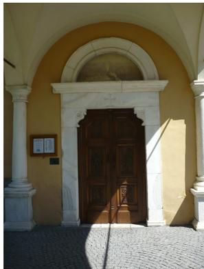
**Fig. 63 : Portale con traverso rettilineo in marmo (Vione, edificio 1.2)**
