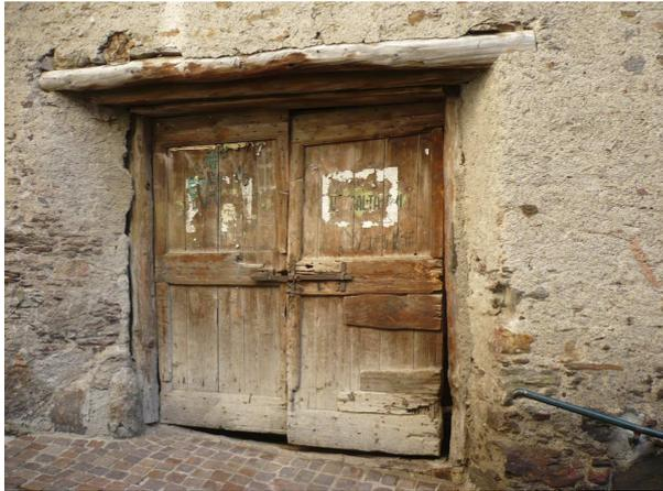
**Fig. 75 : Porta con traverso ad architrave in legno
