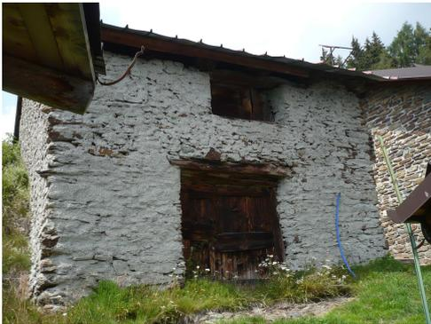
**Fig. 77 : Porta con traverso ad architrave in legno
