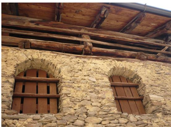
**Fig. 142 : Gronda con travetti in legno
