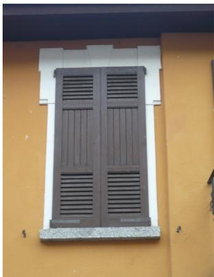
**Fig. 107 : Anta a persiana a battente in legno con doghe verticali (Vione, edificio 1.97)**
