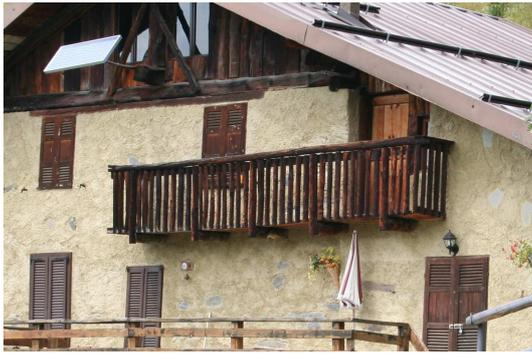
**Fig. 50 : Balcone con struttura e parapetto in legno
