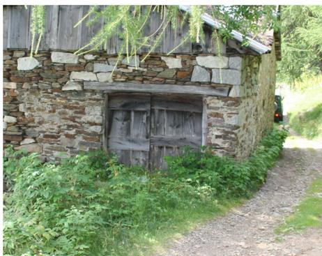
**Fig. 79 : Porta con traverso ad architrave in legno
