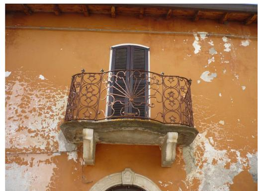
**Fig. 55 : Balcone con struttura e mensole in pietra e parapetto in ferro
