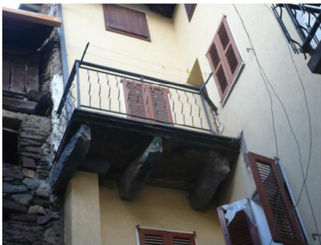
**Fig. 54 : Balcone con struttura in calcestruzzo, mensole in pietra e parapetto in ferro
