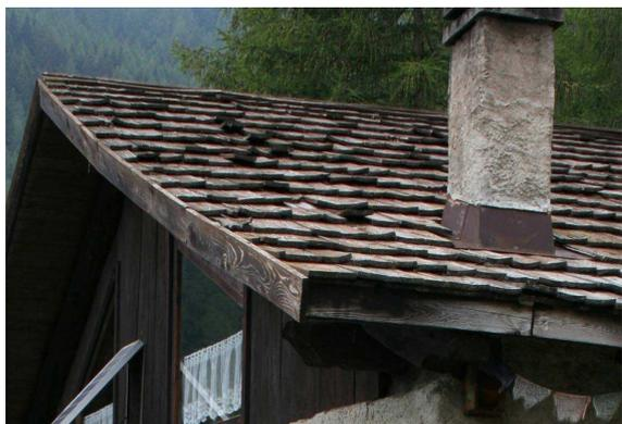
Fig. 134 : Tetto in scandole di legno
