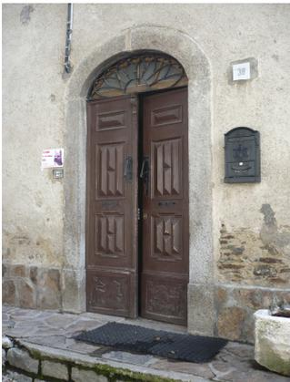
**Fig. 117 : Porta in legno con specchiature
