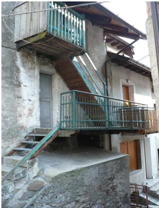
**Fig. 126 : Scala con pedata in legno (Stadolina, edificio 3.11)**
