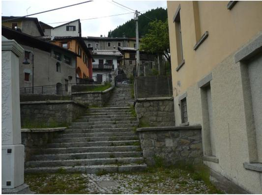
**Fig. 124 : Scala con pedata in blocchi e ciottoli di tonalite (Stadolina, edificio 3.48)**
