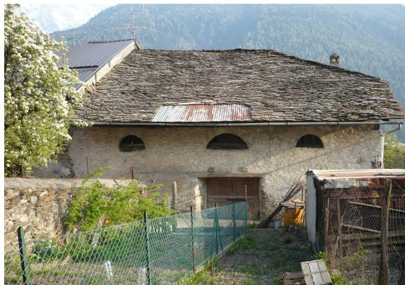
**Fig. 137 : Tetto in lastre di micascisto
