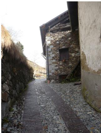
**Fig. 130 : Pavimentazione a smolleri in porfido e ciottoli
