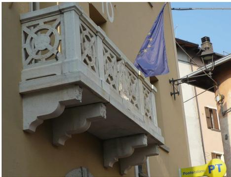
**Fig. 58 : Balcone con struttura, mensole e parapetto in pietra (Vione, edificio 1.88)**
