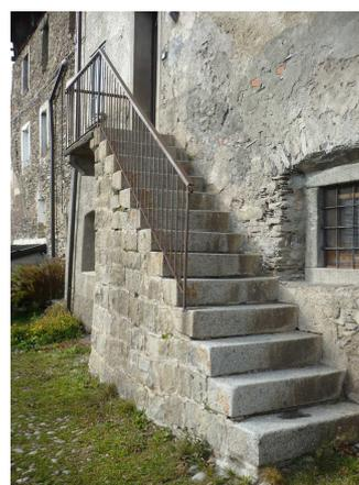
**Fig. 123 : Scala con pedata rettangolare in tonalite
