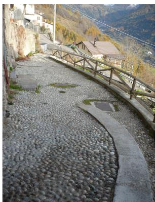
**Fig. 128 : Pavimentazione in ciottoli di fiume
