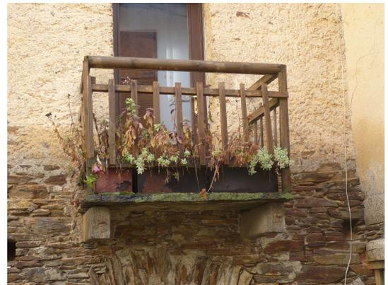
**Fig. 53 : Balcone con struttura e mensole in pietra e parapetto in legno
