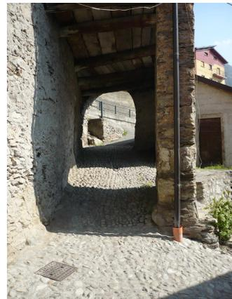
**Fig. 24: Galleria con architrave (Vione, edificio 1.103)**
