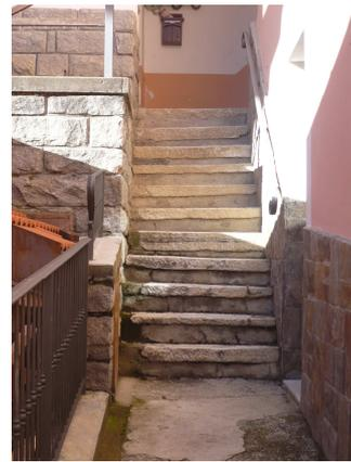
**Fig. 125 : Scala con pedata in marmo (Canè, edificio 2.45)**
