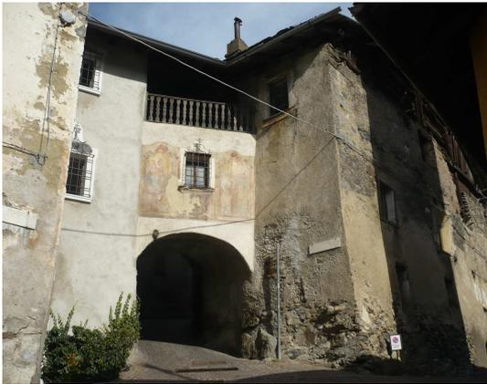
**Fig. 21: Loggia con architrave e porticato con arco (Canè, edificio 2.7)**
