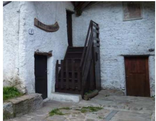
**Fig. 127 : Scala con pedata in legno (Loc. Premia, edificio sparso 97)**
