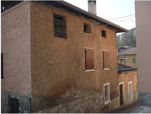
**Fig. 17: Facciata con intonaco strollato
