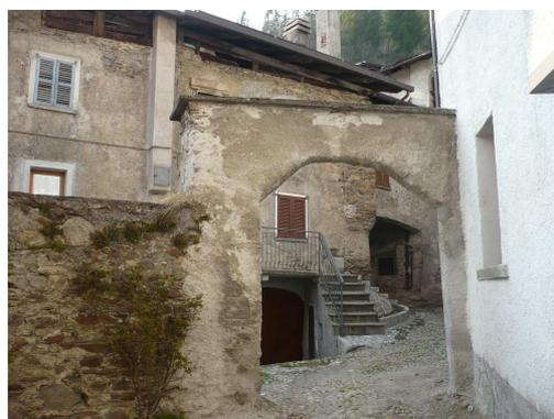
**Fig. 60 : Portone con traverso ad arco irregolare in laterizio (Vione, edificio 1.93)**
