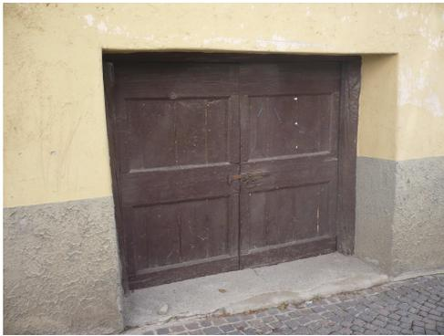
**Fig. 83 : Porta con traverso rettilineo intonacato
