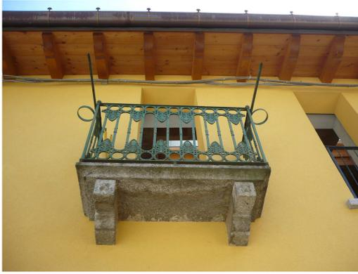
**Fig. 56 : Balcone con struttura e mensole in pietra e parapetto in ferro (Stadolina, edificio 3.86)**
