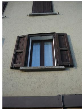
**Fig. 108 : Anta cieca a due battenti con doghe verticali (Canè, edificio 2.65)**
