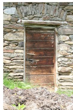
**Fig. 80 : Porta con traverso ad architrave in legno
