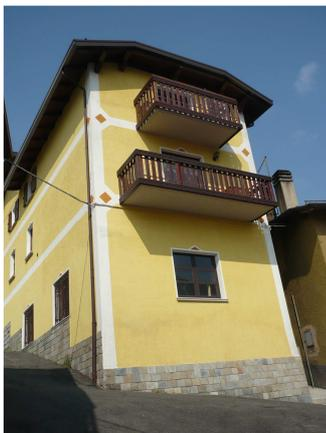
**Fig. 52 : Balcone con struttura in calcestruzzo e parapetto in legno
