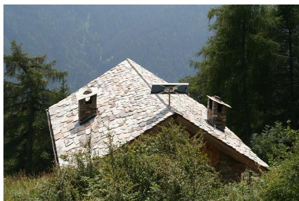
**Fig. 139 : Tetto in lastre di micascisto
