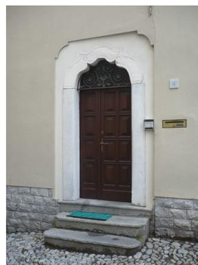
**Fig. 68 : Porta con traverso ad arco inflesso intonacato e piedritti in marmo (Vione, edificio 1.2)**
