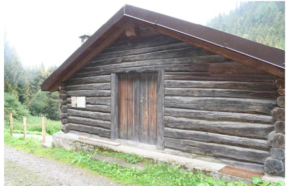
**Fig. 76 : Porta con traverso ad architrave in legno
