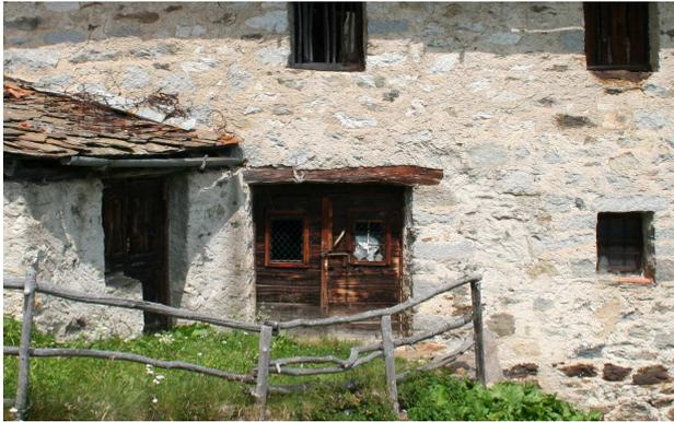
**Fig. 81 : Porta con traverso ad architrave in legno
