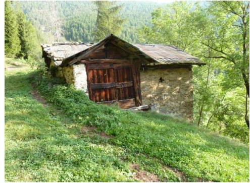
**Fig. 82 : Porta con traverso ad architrave in legno
