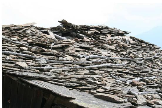
**Fig. 141 : Tetto in lastre di micascisto
