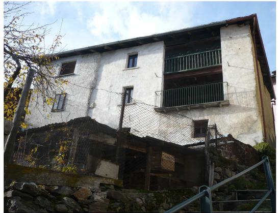
**Fig. 22: Loggia con architravi (Canè, edificio 2.18)**
