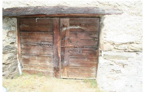
**Fig. 78 : Porta con traverso ad architrave in legno
