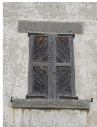
**Fig. 110 : Anta in legno con doghe diagonali (Canè, edificio 2.40)**
