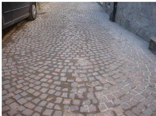
**Fig. 131 : Pavimentazione in cubetti di porfido
