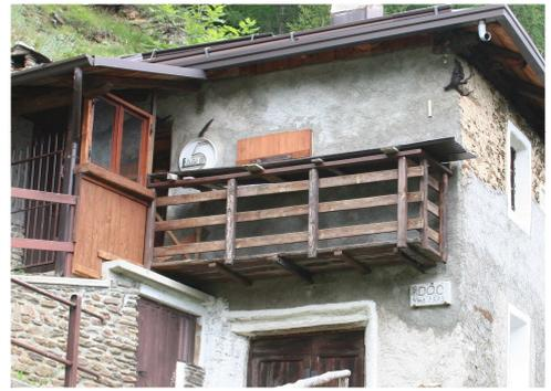
**Fig. 51 : Balcone con struttura e parapetto in legno
